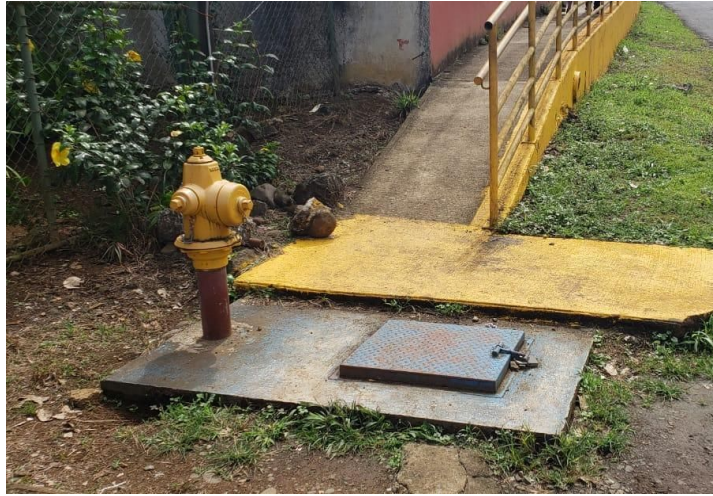
Fotografía 2 Rampa de Acceso Escuela de Santa Rita (JRV 2678)
